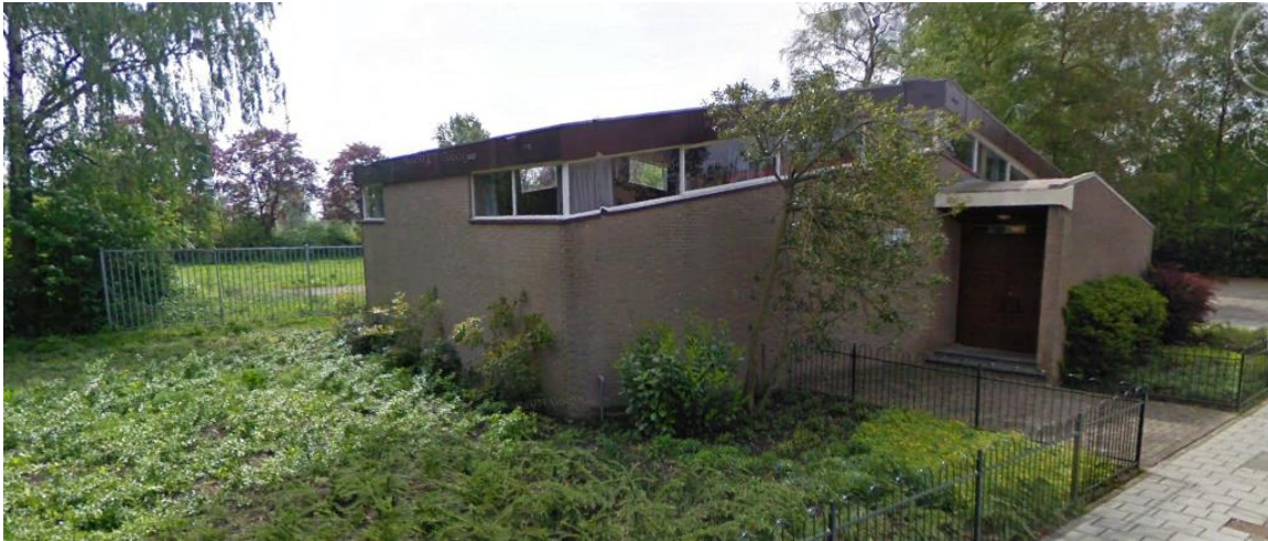
Figuur 2.4: Foto kerkgebouw.
