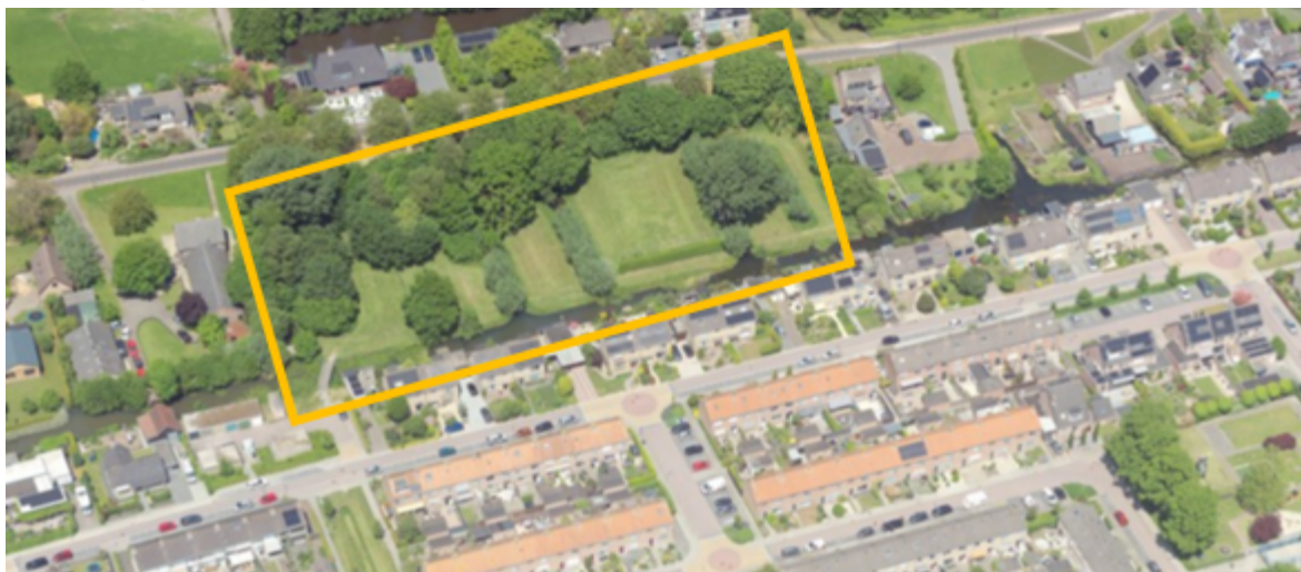
Afbeelding 1. Luchtfoto van het park tussen de Julianastraat en de Voorstraat
