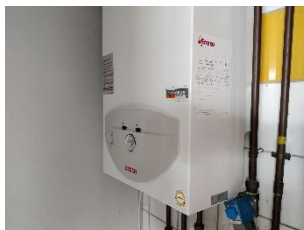
Figuur 4: Geiser t.b.v. douchewater
