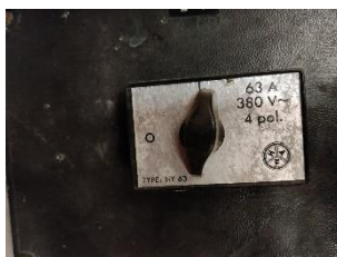
Figuur 8: schakelaar onderverdeler 3x63A
