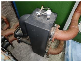
Figuur 6: warmtewisselaar zwembadwater
