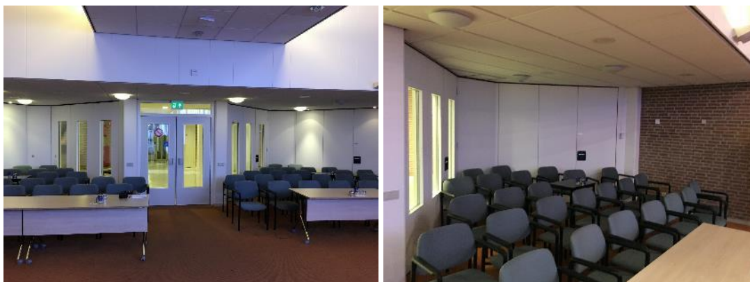
De te verwijderen vouwwand in de huidige raadzaal
