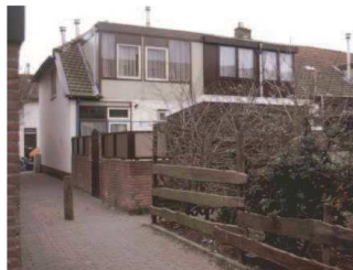
Verstoring van het gevelbeeld als gevolg van een doorgetrokken gevel.
