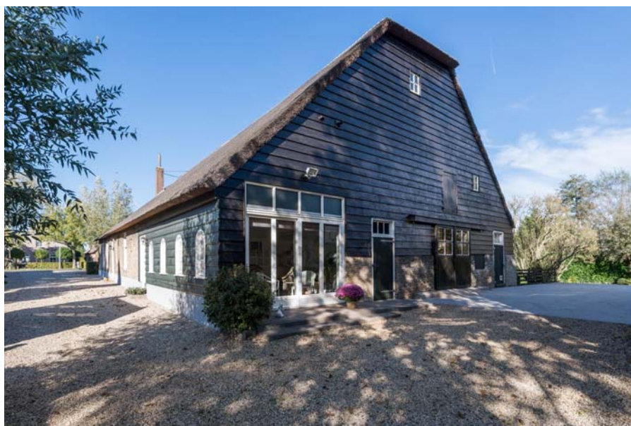
De achtergevel van Graafdijk-West 3 – 4.
