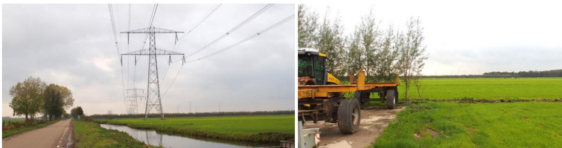
Afb. Twee kenmerkende elementen in het open landschap: De hoogspanningsmasten en de eendenkooi. Hier de eendenkooi gezien vanaf de locatie waar de windmolen gepositioneerd is.
