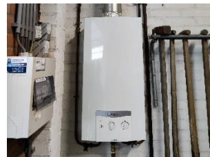
Figuur 5: Geiser t.b.v. douchewater
