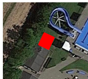
Figuur 18: buitenopstelling warmtepomp
