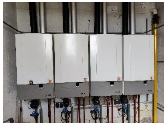
Figuur 3: Cv-ketels voor verwarmen zwembadwater
